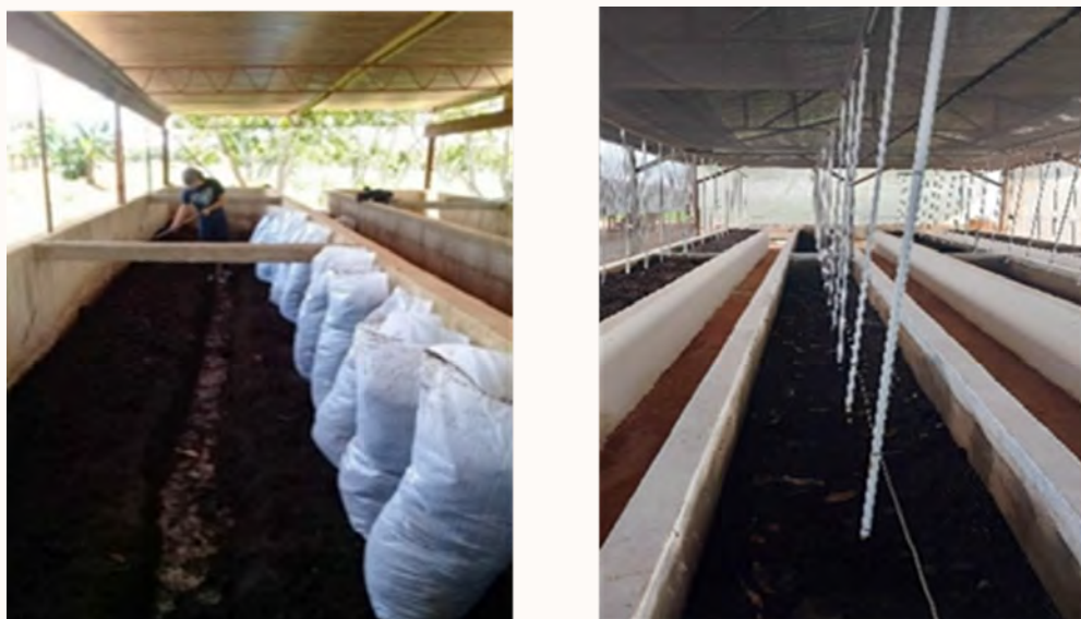
Figura 11. Estructura constructiva de la nave para producir el lixiviado del humus de lombriz.
